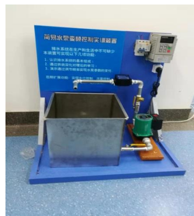
图 12 学生制作水泵变频控制系统
